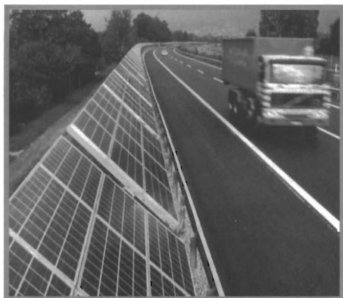
100-kW-Solare-Netzeinspeisung entlang der Autobahn in der Schweiz.
